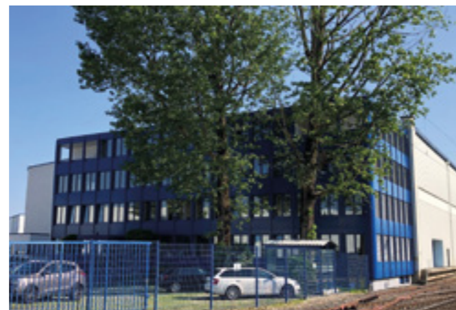
... und nach der Renovierung
